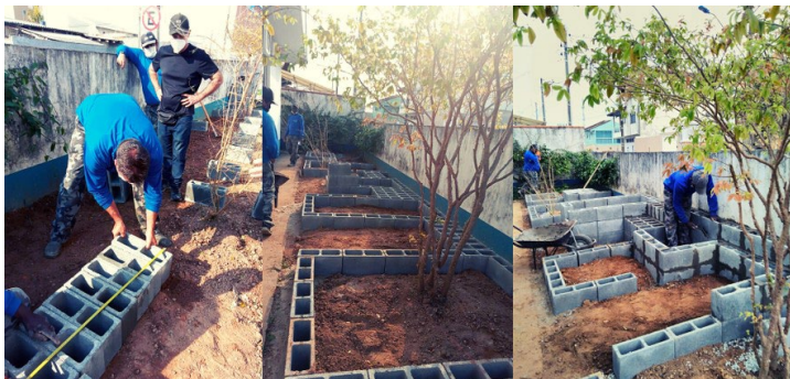
Execução da horta da UBS Costa Cavalcante Autor: Projeto de extensão Arquitetura e Cidades Saudáveis (2021).
